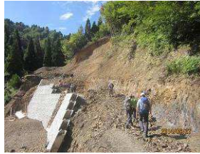
工事現場です
